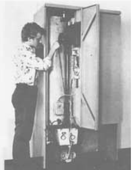
Fig. 18. Brugsvandsføleren (mærket med V) stikkes ind i følerlommen i VV-beholderen, og max. fremløbsføleren (mærket med B) stikkes ind i følerlommen i bufferbeholderen. (Bemærk om der er termopasta i lommerne).
