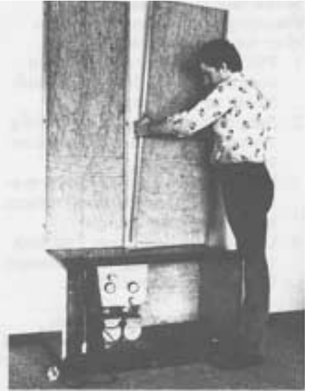
Fig. 6. Herefter skydes bagerste beklædningsplader på plads. (Bemærk nøglehulsudsparring for skruerne).
