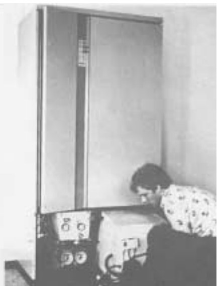
Fig. 21. Montering af varmepumpemodul.
