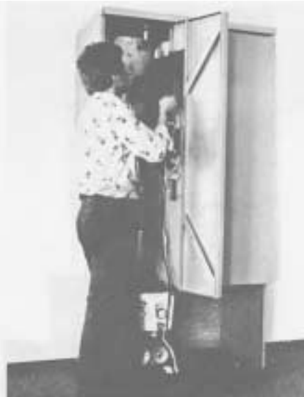
Fig. 17. Styring monteres bag på venstre låge. (Bemærk om styrepanel sidder lige i lågens udsparring), og om styringens afdækningskærm går fri af kappepumpe).
