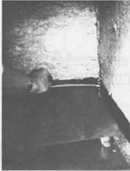
Fig. 5. Varmepumpesokkel rettes op, således at den står vandret. (Få et stabilt underlag anbragt under justeringsskruer, f.eks. en jernplade).
