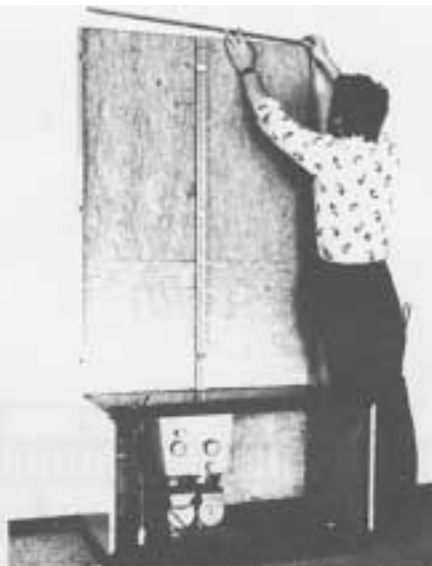
Fig. 8. Styreskinne monteres på overkant af bagbeklædningen.
