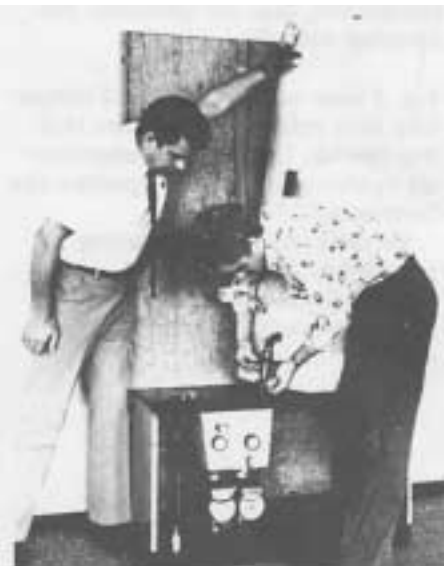
Fig. 9. Varmtvandsbeholder monteres på sokkel. (Husk Ø-ring og flange på returløbsstuds for tætning til sokkel). Beholderen befæstiges til sokkel med 3 stk. maskinskrue underop. Løftejæ på beholdertop fjernes.
