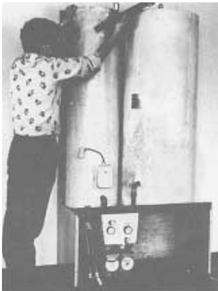
Fig. 10. Bufferholderen monteres tilsvarende varmtvandsbeholderen. Husk også her Ø-ring og flange! (Vær opmærksom når ventilarrangementet stikkes ned gennem udsparring i sokkel, så hverken ventil eller kabel beskadiges). Kabelgennemføring sættes på plads i udsparring. Bufferholderen befæstiges til sokkel med 2 stk. maskinskrue underop. Indbyrdes afstøtning monteres på beholdernes top.
