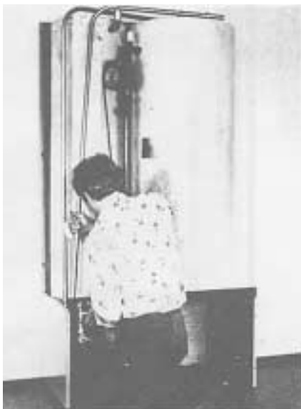
Fig. 13. Koldt vandstilgang og varmtvandsafgang monteres og forbindes videre til anlæg.
