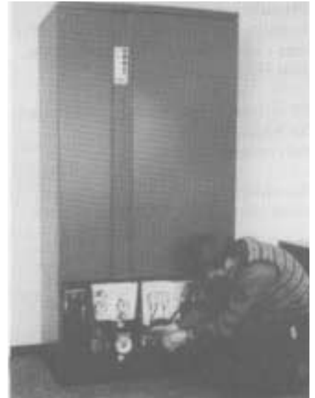
Fig. 24. Modulet tilkobles til styre- og driftstrøm på multistik. (Ang. opstart af nyt anlæg: se instruktion for igangsætning).
